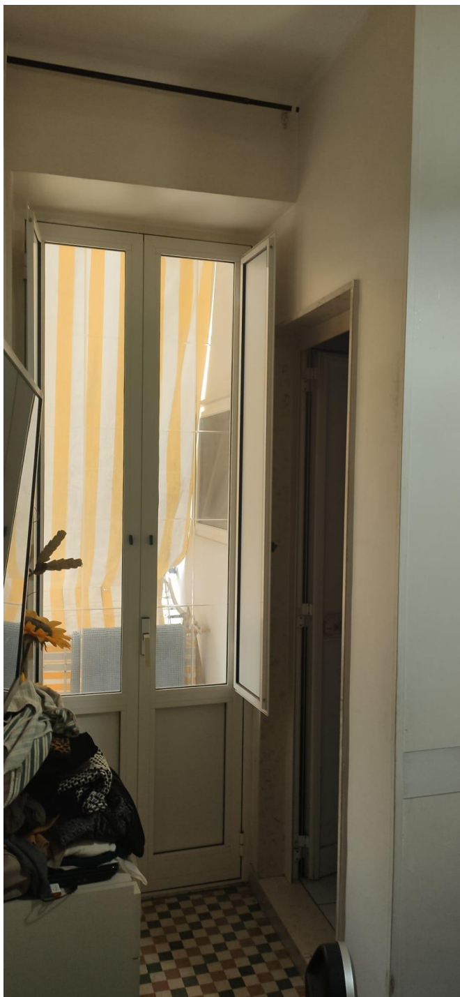
Foto n. 5, vista ingresso bagno
